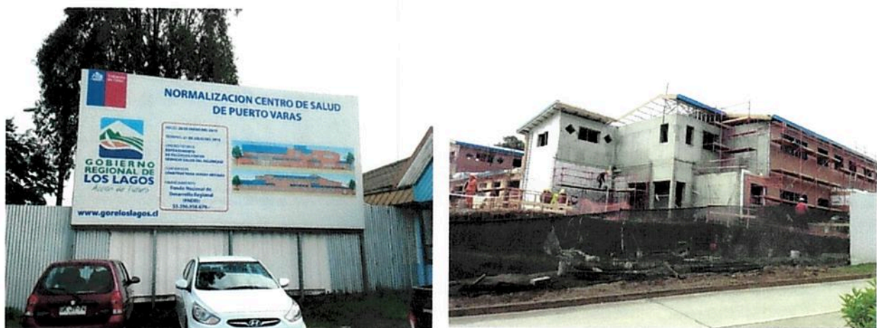
Figura 9 Obra de construcción CESFAM
