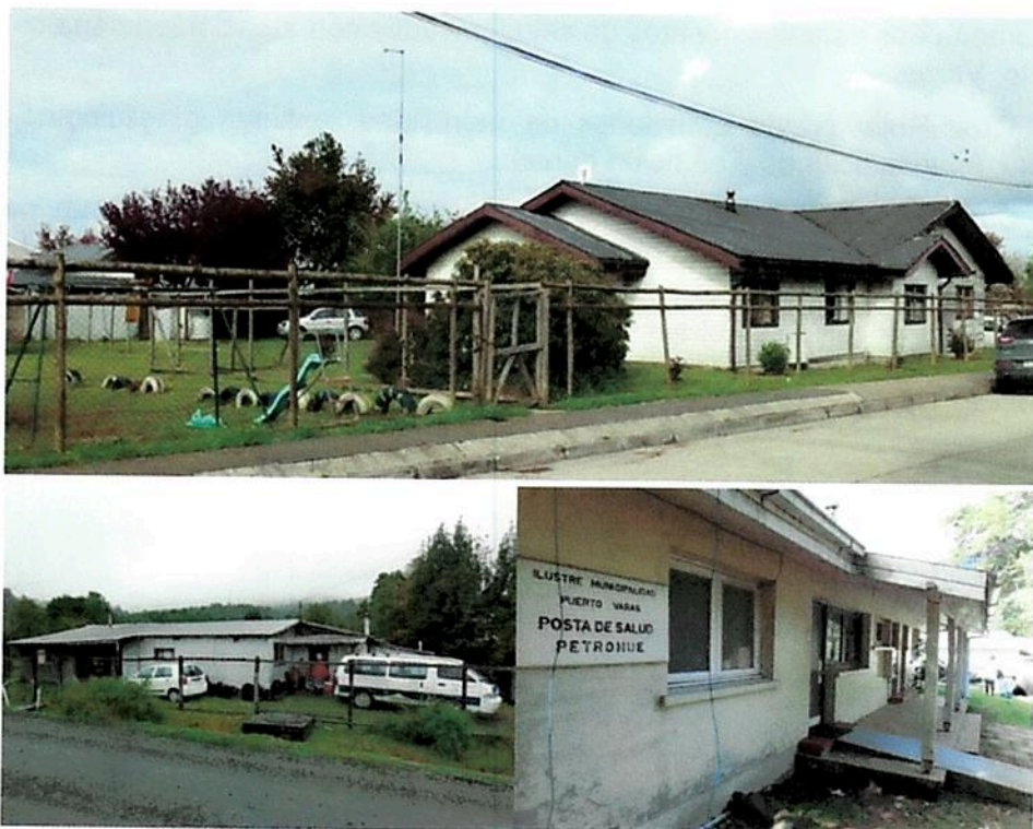
Figura 4 Posta Nueva Braunau, Posta Rural Río Sur y Posta de Salud Rural Petrohué
