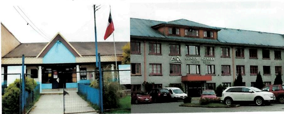
Figura 6 CESFAM y Clínica Alemana de Puerto Varas
